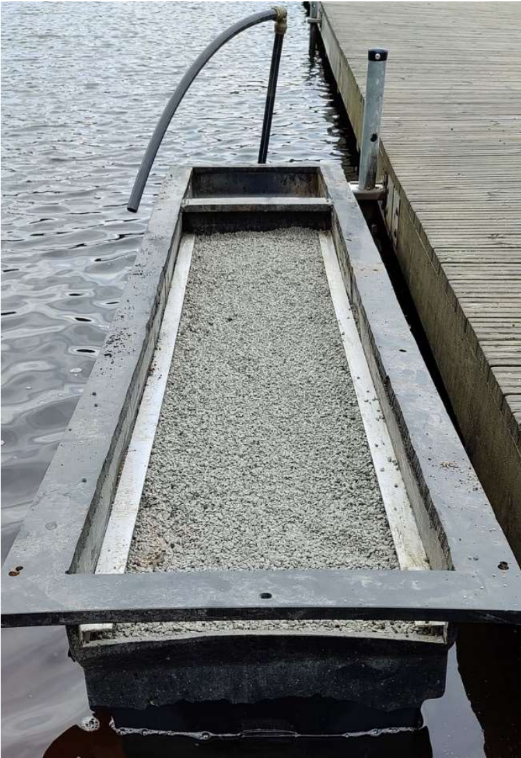
Kuva 4: Biosuodattimen karkein hiekka/sepelikerros ennen asentamista
