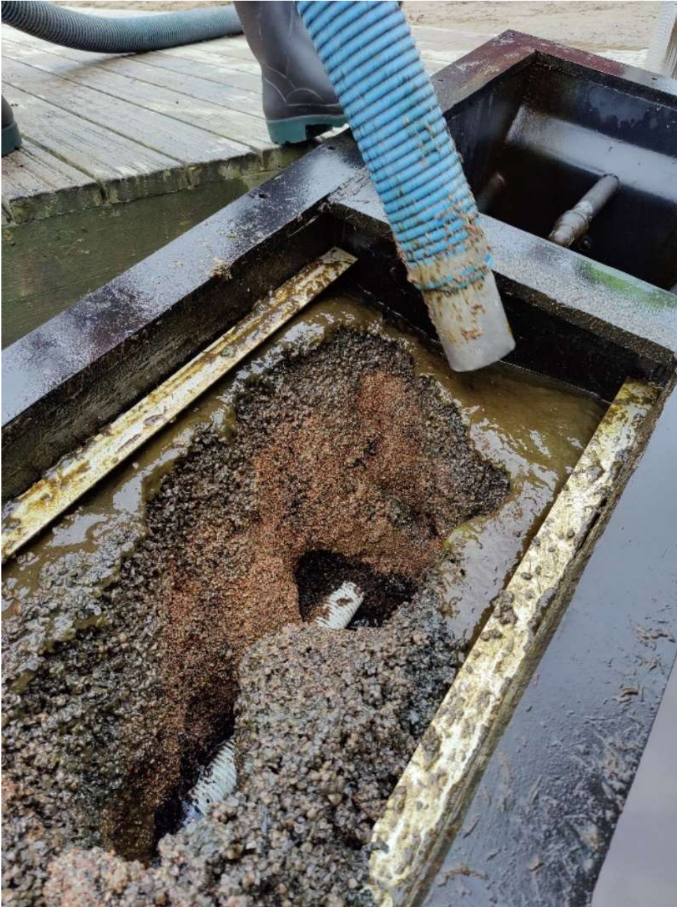
Kuva 7: Biosuodattimen tyhjennys imuautolla.
