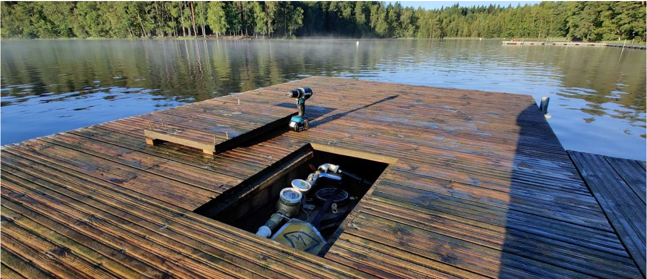
Kuva 1: Kuusijärven biosuodattimen tarkastus käynnissä huoltoluukun kautta
